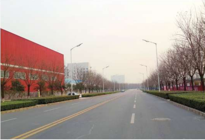
● 洛阳市春城路 Luoyang Chuncheng road
