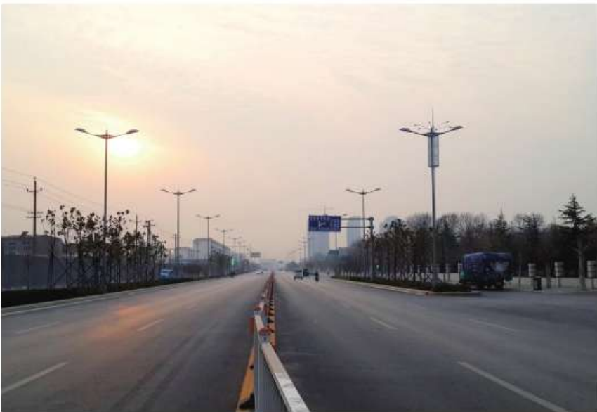
● 洛阳市河洛路 Luoyang Heluo road
