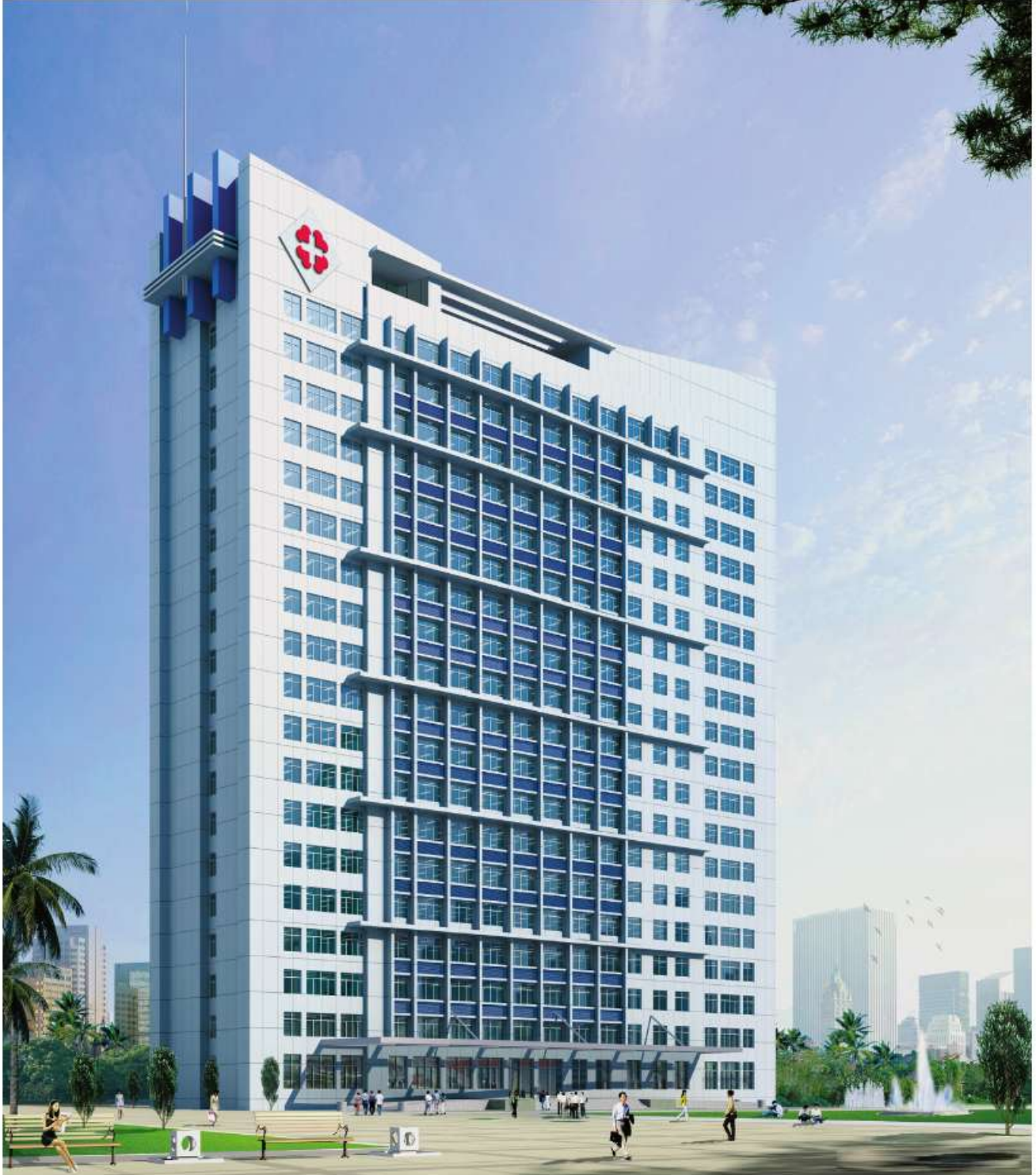
● 中俄心血管治疗中心综合楼
