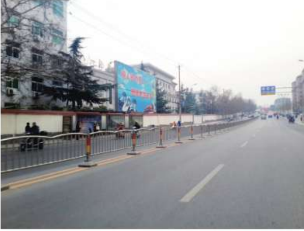
● 洛阳天津南路改造工程 Luoyang Tianjin south road modification works
