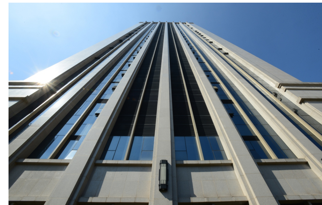
五矿万境财智中心石材外墙
