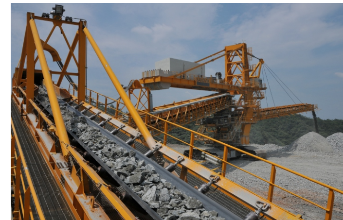
江铜集团德兴铜矿废石胶带运输系统
